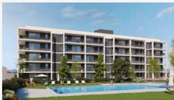
Edificio Tasman. Sant Just Desvern.
